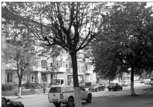
Дом №3, построенный против прежнего выхода ул. Госпитальной на ул. Ленина. Под его центром (под магазинами) когда-то стояла старая реформатская церковь, где размещался русский госпиталь.
