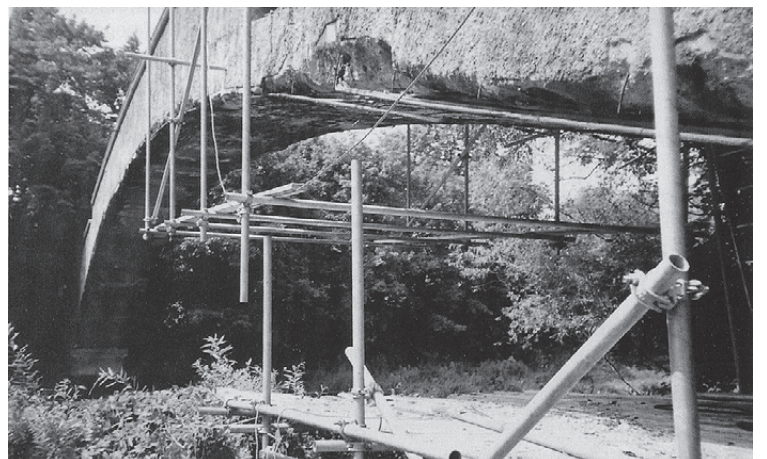
Реставрация Арочного моста
