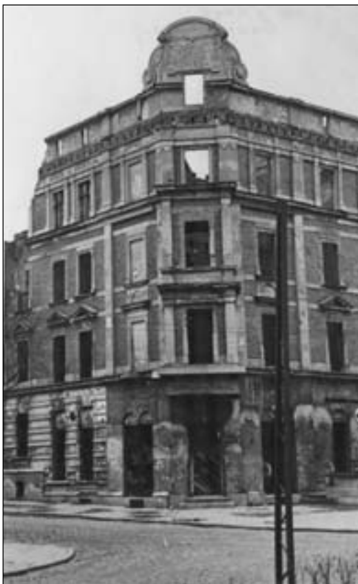
Инстербург после боев. Перекресток Дойчештрассе и Вильгельмштрассе.
